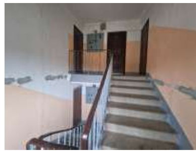
5.stāva kāpņu telpa
